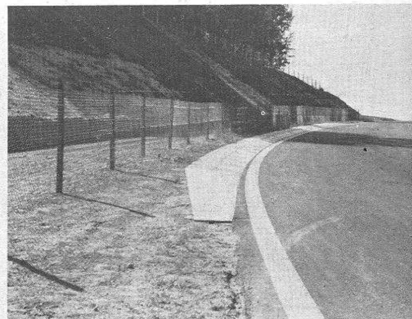
Quasi tutte le curve del Mugello sono state « ritoccate » per quel che riguarda le misure di sicurezza: gran parte delle barriere metalliche sono state arretrate, come possiamo vedere alle curve S. Donato (sopra) e Poggio Secco (sotto)
