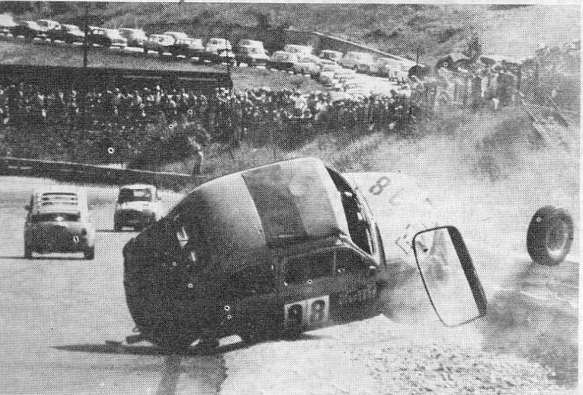
La rottura del mozzo della ruota posteriore destra della sua 500 ha giocato un brutto scherzo a Giancarlo Segalini, nel corso della gara per le minime cilindrata a Varano. Ecco la vettura piroettare alla curva della « Ickx »
